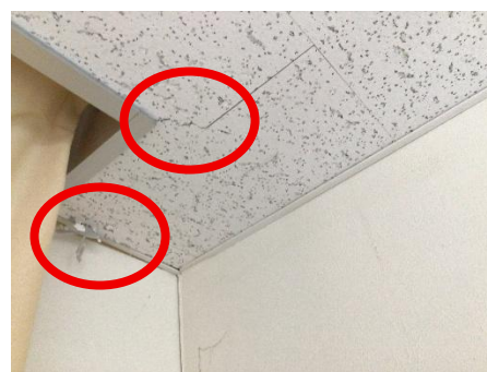
職員室の壁・天井のひび割れ
